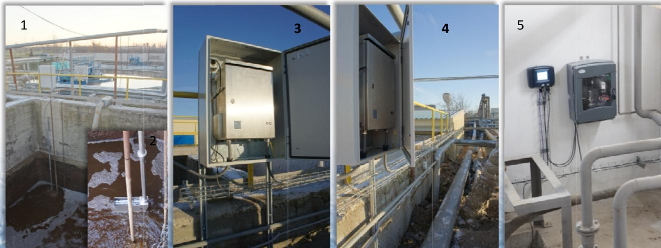
Анализатор Phosphax был подключен к универсальному контроллеру sc1000 с цифровым сенсорным дисплеем и со встроенным интерфейсом ProfiBus для передачи результатов измерений, а также статуса и ошибок прибора на АРМ в операторской очистных сооружений.
